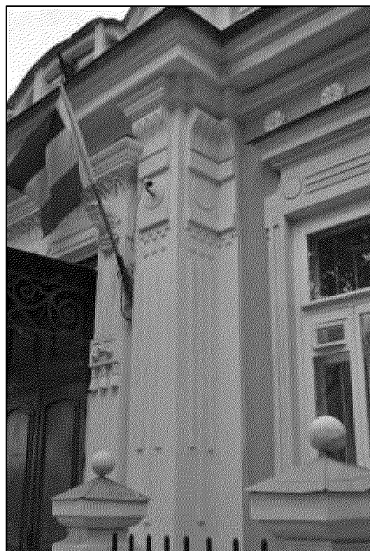
фрагмент юго-западного ризалита главного юго-восточного фасада литеры В, в объекта культурного наследия (пилястры, оформленные стилизованной капителью в виде модульона с триглифом над плакеткой с кнопкой и дополненные зубчиками с косицами на теле пилястр)
