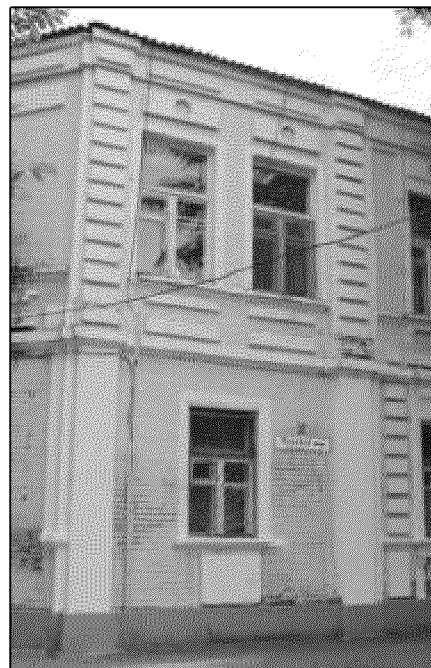
фрагмент парадного северо-западного фасада объекта культурного наследия (крайняя северная раскреповка, фланкированная рустованными лопатками в уровне второго этажа и гладкими лопатками в уровне первого этажа)
