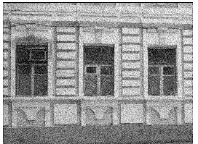
фрагмент парадного северо-восточного фасада объекта культурного наследия в уровне первого этажа (оконные проемы, обрамленные наличниками с замками и накладными элементами, подоконные ниши с накладными декоративными элементами, рустованные лопатки в межоконных простенках)
