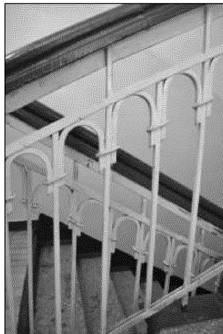
металлическое ажурное ограждение внутренней междуэтажной парадной двухмаршевой лестницы в центральной части объекта культурного наследия
