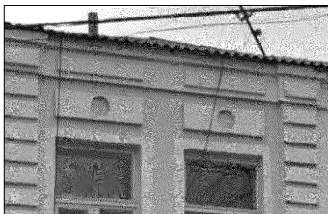
фрагмент парадного северо-западного фасада объекта культурного наследия (слабовыступающий простой венчающий карниз, гладкий фриз с прямоугольными плакетками, подчеркивающими ритм оконных проемов)
