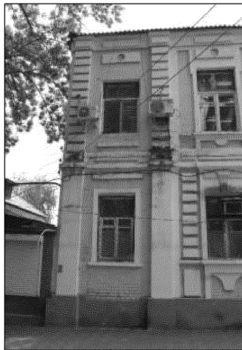
фрагмент парадного северо-восточного фасада объекта культурного наследия (крайняя восточная раскреповка, фланкированная рустованными лопатками в уровне второго этажа и гладкими лопатками в уровне первого этажа)
