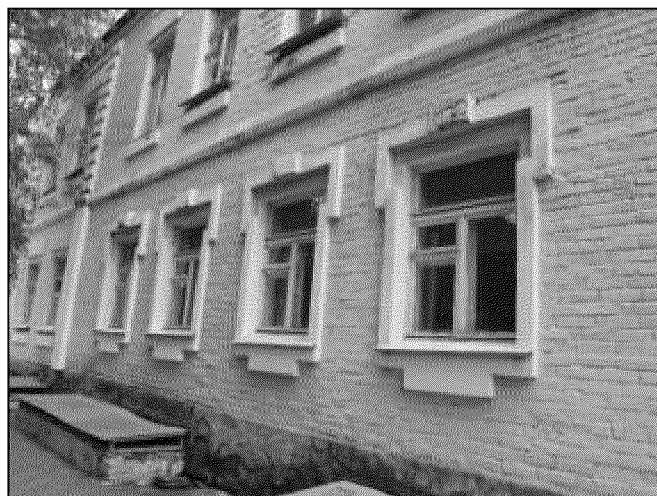
фрагмент парадного северо-западного фасада объекта культурного наследия в уровне первого этажа (широкий междуэтажный пояс, оконные проемы, обрамленные гладкими кирпичными наличниками с замками и ушками)
