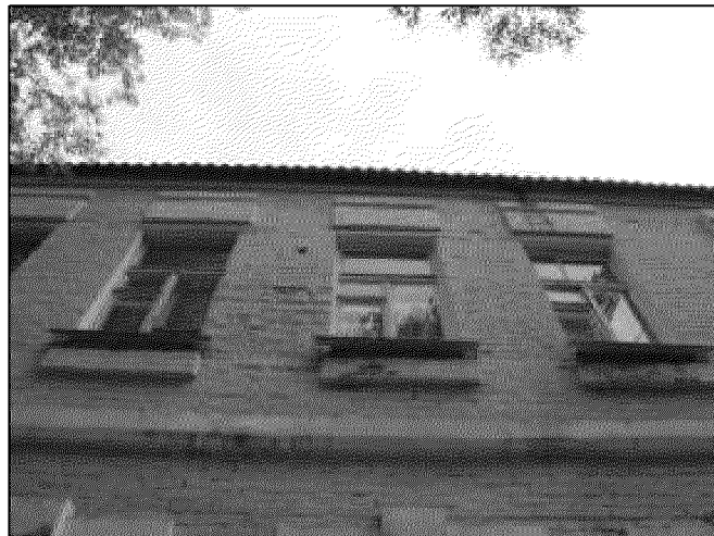
фрагмент парадного северо-западного фасада объекта культурного наследия в уровне второго этажа (прямоугольные надоконные и подоконные плакетки, широкий междуэтажный пояс)
