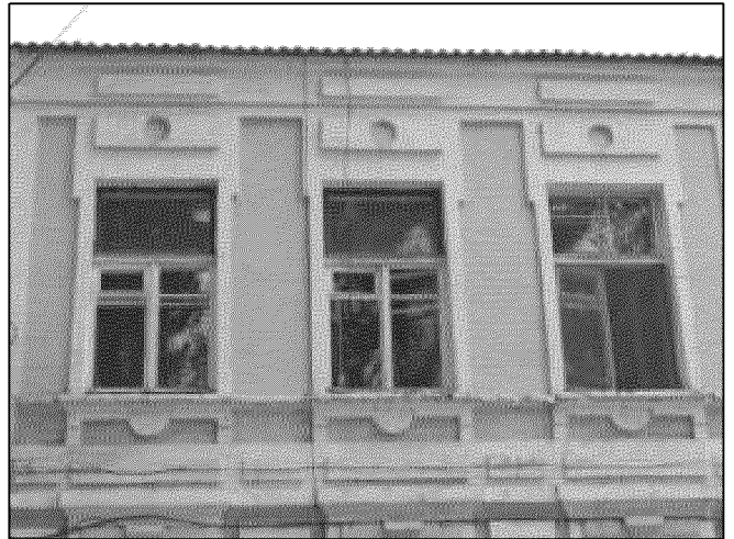
фрагмент парадного северо-восточного фасада объекта культурного наследия в уровне второго этажа (оконные проемы с контрналичниками с ушками и накладными элементами, декоративные элементы в подоконной части)
