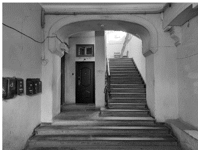
вестибюль парадной лестницы
