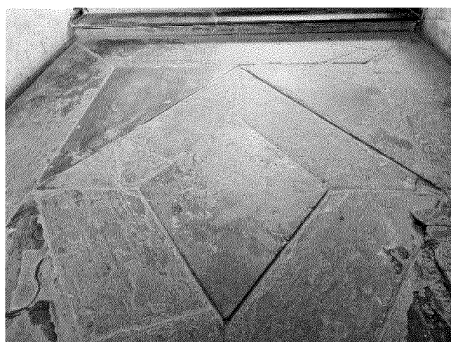
покрытие пола вестибюля парадной лестницы
