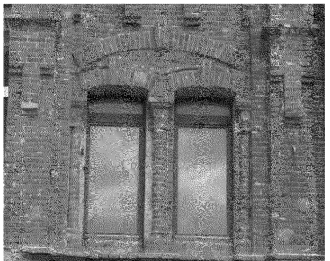
парные оконные проемы второго этажа боковых раскреповок
