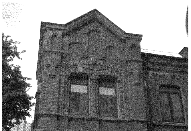
лопатки с декоративными Т-образными накладками, расположенные в простенках проемов и фланкирующие раскреповки в уровне второго этажа
