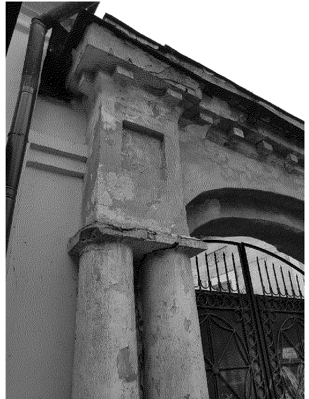
парные трехчетвертные колонны упрощенного ордера, фланкирующие проем ворот объекта культурного наследия
