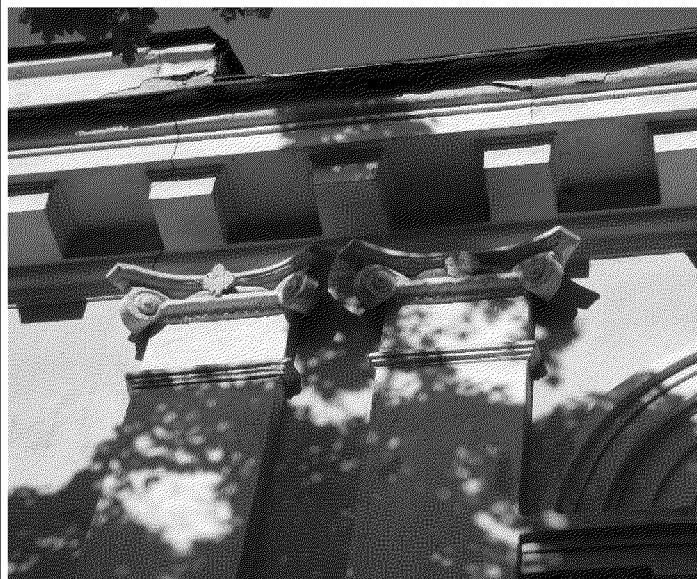
широкий навесной венчающий карниз на массивных сухариках на юго-восточном фасаде литера А
