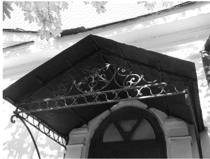
металлический ажурный козырек первоначального входа на главном юго- восточном фасаде литера Б
