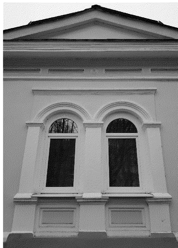
оконные проемы с полуциркульным завершением на главном юго-восточном фасаде литера Б объекта культурного наследия
