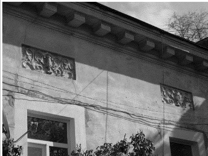
широкие прямоугольные ниши заполненные растительным лепным орнаментом на северо-западном дворовом фасаде литера А
