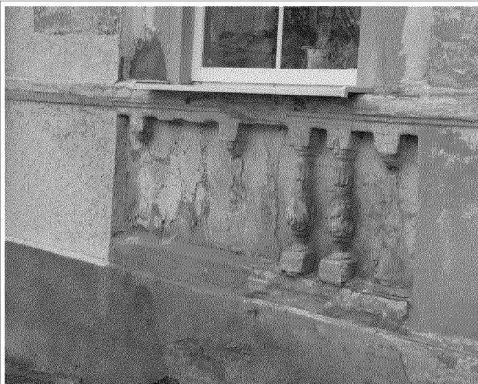
балясник в подоконной нише на главном северо-восточном фасаде объекта культурного наследия
