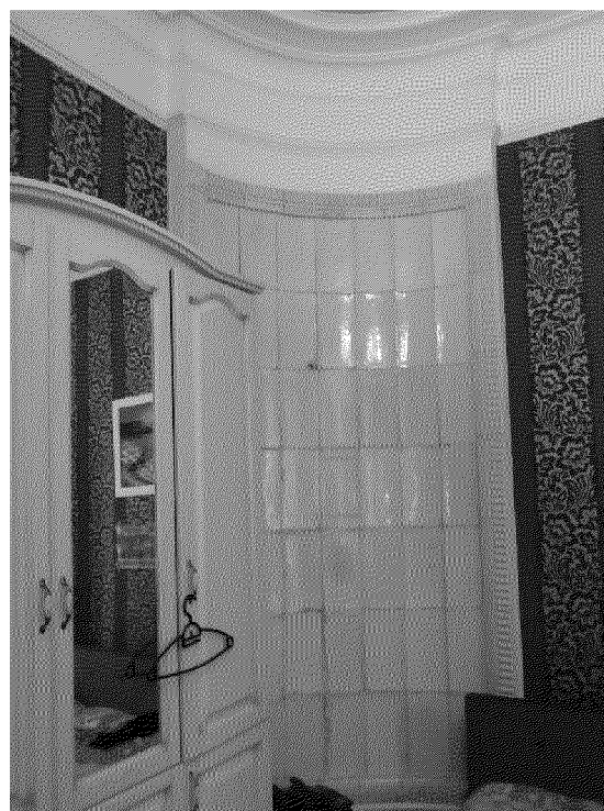
зеркало печи в помещении № 5 объекта культурного наследия
