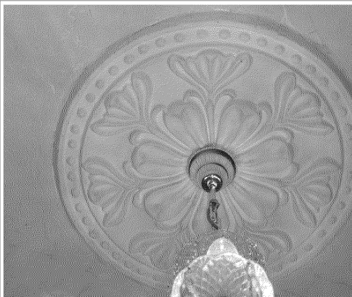
циркулярная розетка с лепным декором растительного орнамента и профилированными поясками в помещении № 7 объекта культурного наследия
