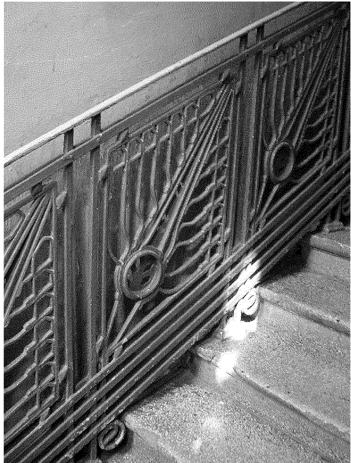
первоначальное металлическое ограждение лестницы
