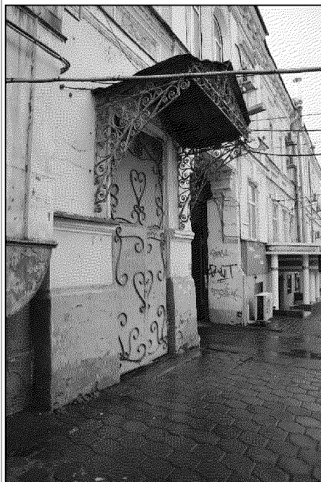
ажурный кованый козырек на кронштейнах на юго-восточном фасаде
