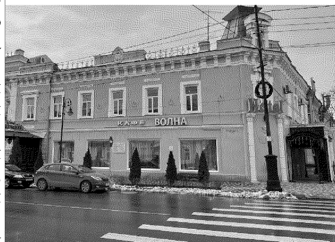
общий вид угловой части объекта с юга
