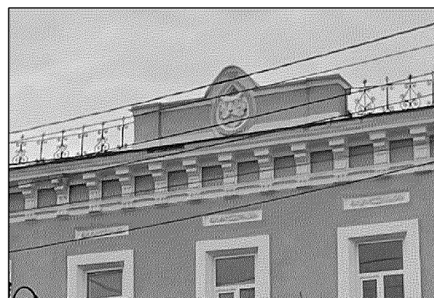
аттик с маскаронном и фризвый пояс с рядом модульонов с триглифами и гуттами в архитраве центральной части юго-западного фасада объекта
