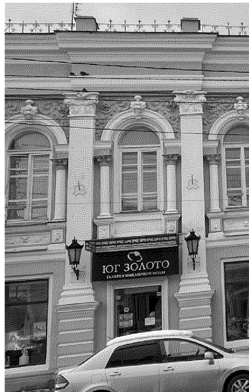
центральная раскреповка западной части юго-западного фасада
