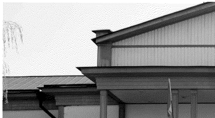
деревянные обшивные карнизы
