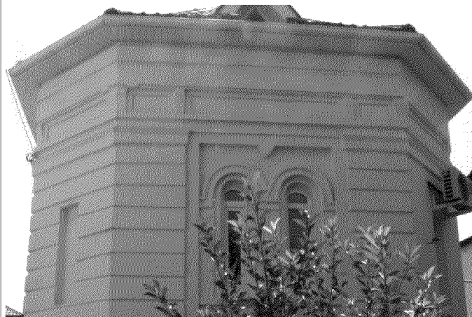
архитектурное оформление оконных проемов в уровне второго этажа, французский руст в обработке северо-западного фасада объекта культурного наследия (фото 07.2021 г.);
