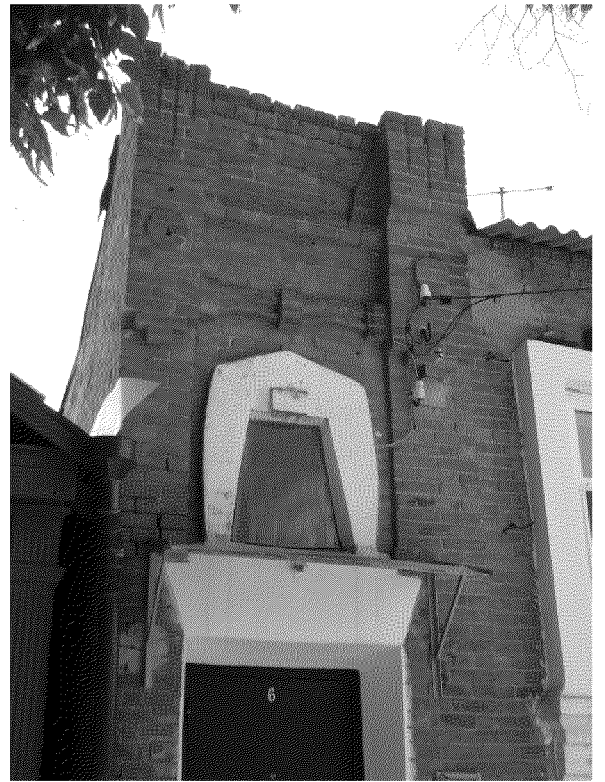
архитектурное оформление раскреповки в восточной части главного фасада объекта культурного наследия (фото 07.2021 г.);
