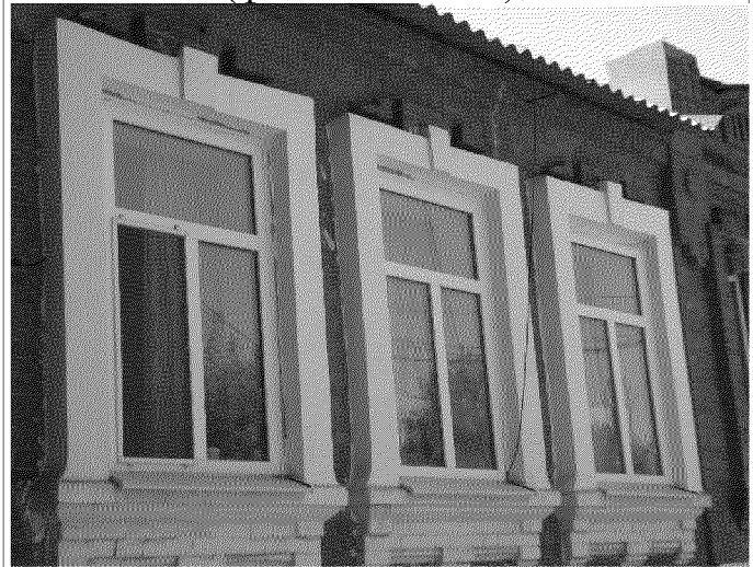
архитектурное оформление оконных проемов в уровне первого этажа на главном северо-западном фасаде объекта культурного наследия (фото 07.2021 г.)
