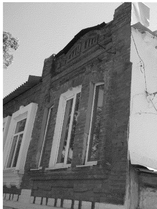
архитектурное оформление раскреповки в западной части главного фасада объекта культурного наследия (фото 07.2021 г.);
