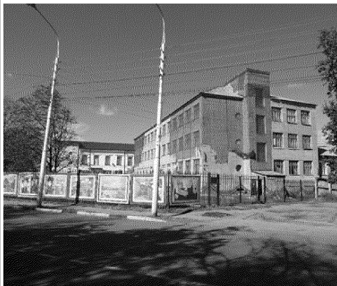
восточный и южный фасады литера А, восточный фасад литера А1 (архивное фото 2019 г.);
