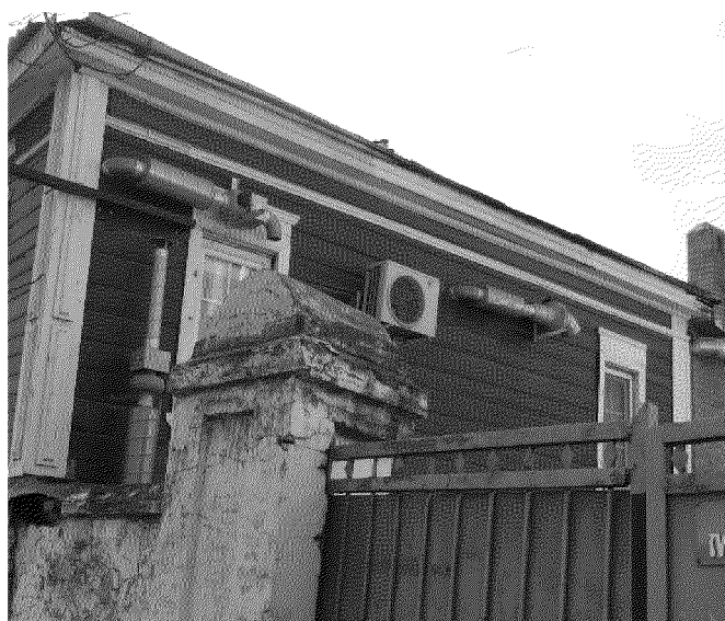
обшивной карниз и оконные проемы на северо-западном фасаде (фото 01.2021 г.)
