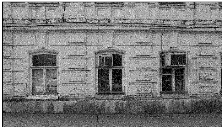
фрагмент парадного северо-восточного фасада объекта культурного наследия в уровне первого этажа (рустованные лопатки с плакетками, замковый камень в оформлении оконного проема, цоколь, фото 04.2021 года);
