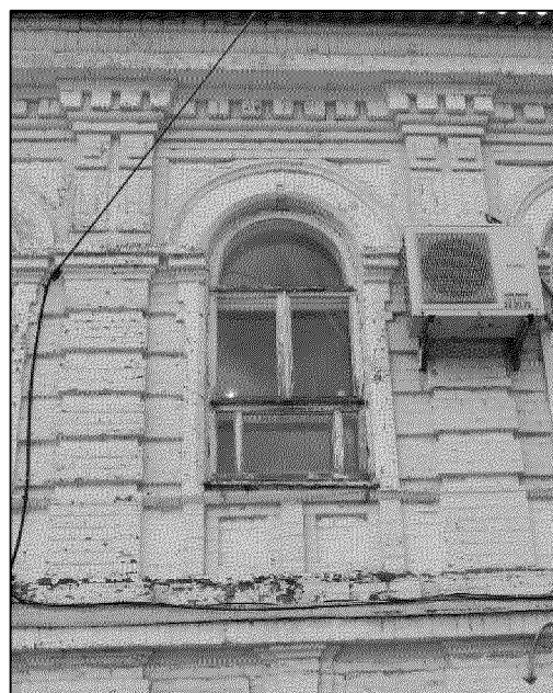
фрагмент парадного юго-восточного фасада объекта культурного наследия в уровне второго этажа (архивольты и плоские наличники с ушками, рустованные пилястры и стены, широкий пояс с чередой прямоугольных подоконных филенок и прямоугольных ниш, фото 04.2021 года);
