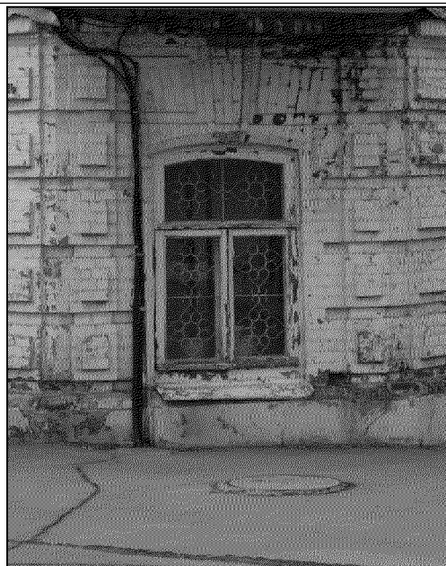
фрагмент угловой восточной части объекта культурного наследия в уровне первого этажа (рустованные лопатки с плакетками, замковый камень в оформлении оконного проема, цоколь, фото 04.2021 года);
