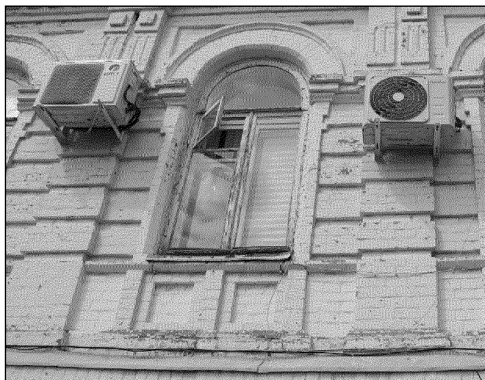
фрагмент парадного юго-восточного фасада объекта культурного наследия в уровне второго этажа (архивольты и плоские наличники с ушками, рустованные пилястры и стены, широкий пояс с чередой прямоугольных подоконных филенок и прямоугольных ниш, фото 04.2021 года);
