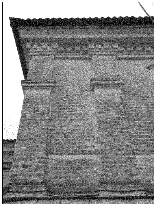
фрагмент выступающей части дворового юго-западного фасада объекта культурного наследия (парные пилястры с профилированными поясками, фланкирующие углы дворового юго-западного фасада, фото 04.2021 года);
