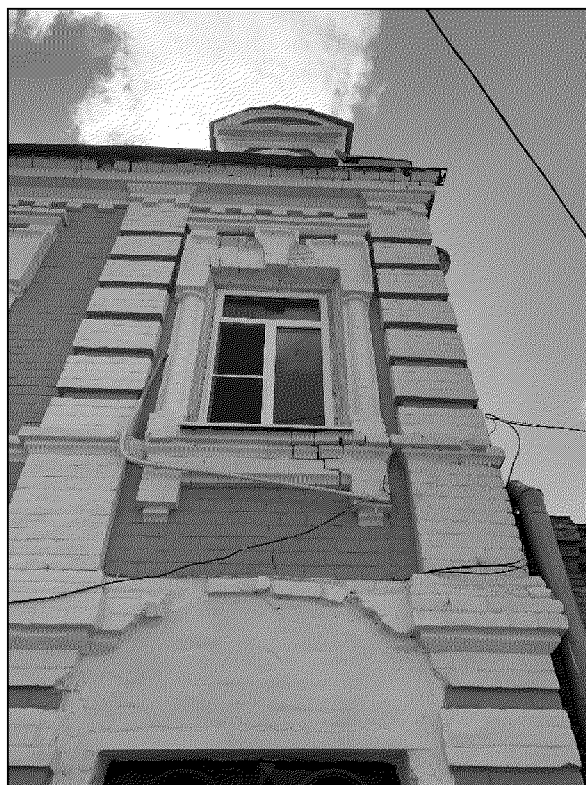
фрагмент главного северного фасада объекта культурного наследия (крайняя западная раскреповка в уровне второго этажа, фото 02.2021 года);
