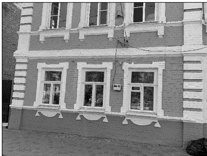
фрагмент главного северного фасада объекта культурного наследия в уровне первого этажа (фото 02.2021 года);
