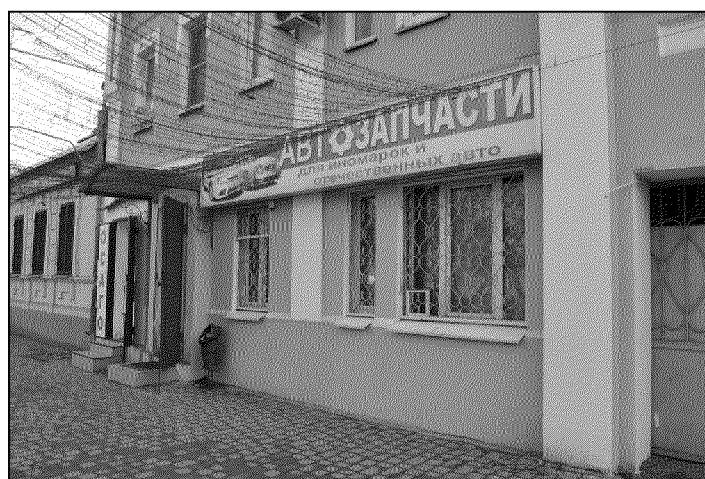
фрагмент главного северного фасада объекта культурного наследия в уровне первого этажа (фото 02.2021 года);
