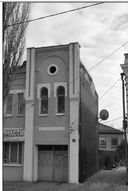
фрагмент главного северного фасада объекта культурного наследия (крайняя западная раскреповка, фото 02.2021 года);
