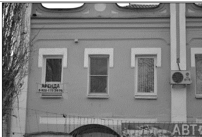
фрагмент восточной части главного северного фасада объекта культурного наследия в уровне второго этажа (фото 02.2021 года);
