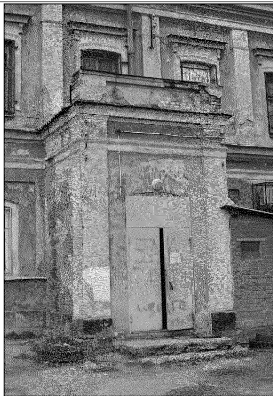
фрагмент дворового юго-восточного фасада объекта культурного наследия (тамбур входа, фото 04.2021 года);
