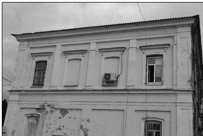
фрагмент дворового юго-западного фасада объекта культурного наследия в уровне второго этажа (венчающий карниз, пилястры, сандрики на небольших декоративных кронштейнах, фото 04.2021 года)
