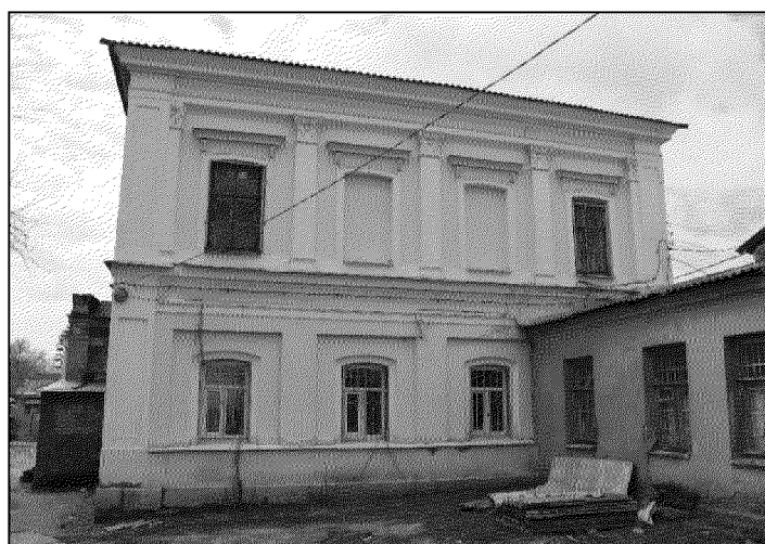
дворовый северо-восточный фасад объекта культурного наследия (фото 04.2021 года);
