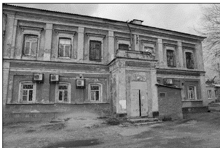
дворовый юго-восточный фасад объекта культурного наследия (фото 04.2021 года);
