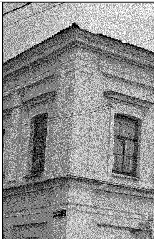
угловая пилястра главного северо-западного и дворового юго-западного фасадов, оформленные неглубокими вертикальными нишами в уровне второго этажа (фото 04.2021 года);
