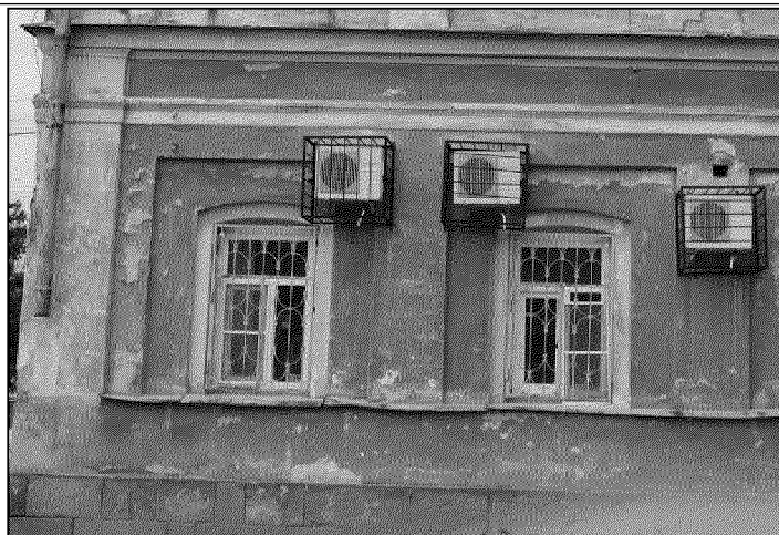
фрагмент дворового юго-восточного фасада объекта культурного наследия в уровне первого этажа (фото 04.2021 года);
