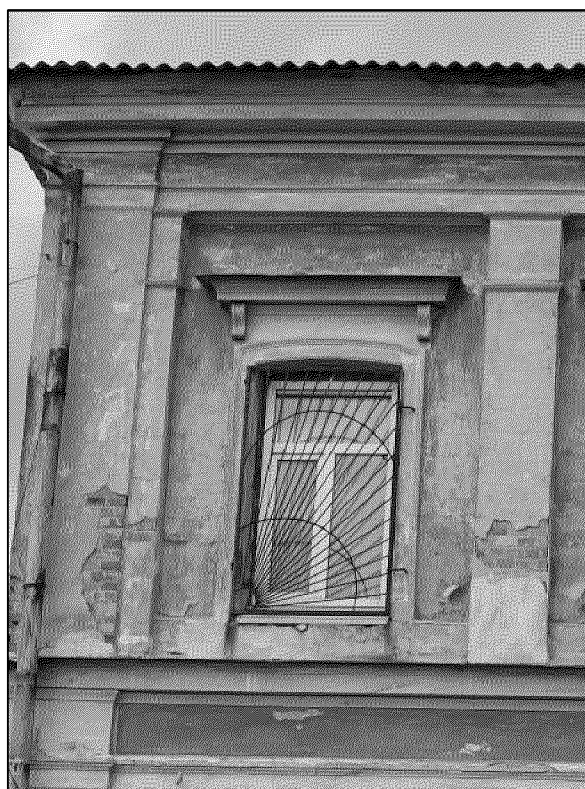
фрагмент дворового юго-восточного фасада объекта культурного наследия в уровне второго этажа (венчающий карниз, пилястры, сандрики на небольших декоративных кронштейнах, фото 04.2021 года);
