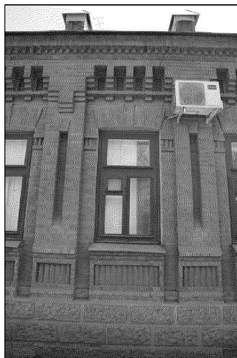
фрагмент главного юго-западного фасада объекта культурного наследия (фризовый пояс, простеночные лопатки, декоративные вставки, цоколь, фото 05.2021 года);
