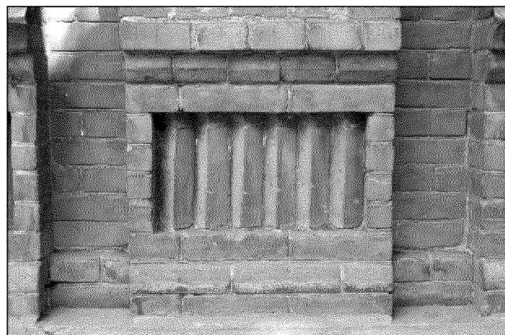
фрагмент главного юго-западного фасада объекта культурного наследия (декоративная вставка поребрика в оформлении простеночной лопатки, фото 05.2021 года)
