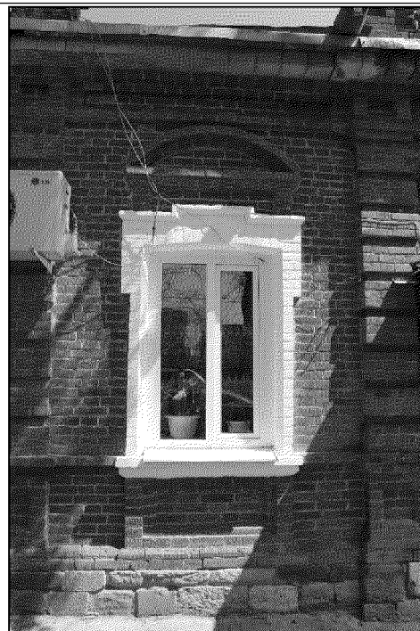
фрагмент главного юго-западного фасада объекта культурного наследия (рустованные лопатки, сандрик, наличник, подоконный пояс с нишами, фото 05.2021 года);
