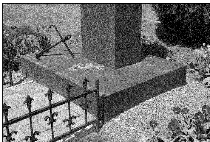
основание объекта культурного наследия (фото 05.2021 года)
