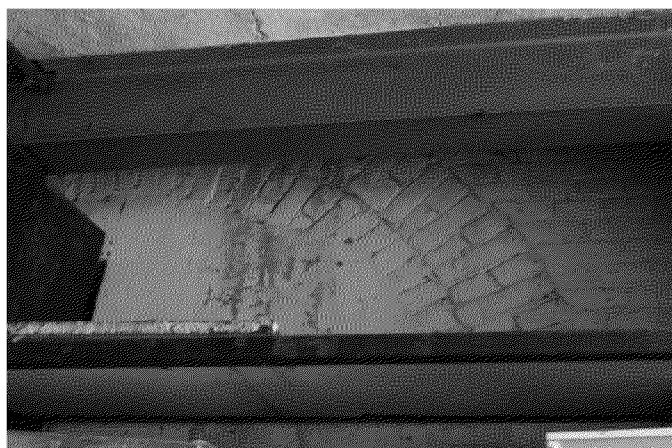
фрагмент кирпичной кладки с аркой на внутренней стене
