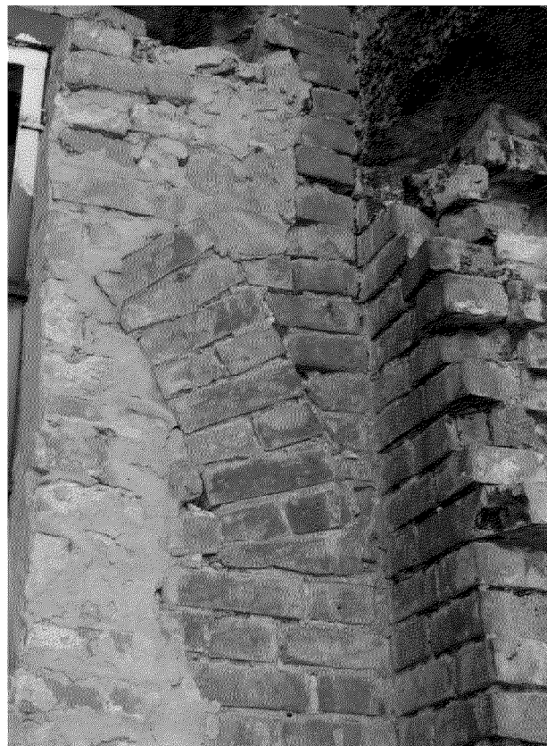
фрагмент кирпичной кладки с аркой на наружной северо-восточной стене;
