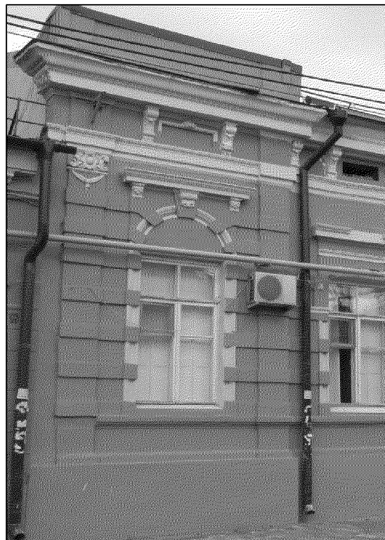
фрагмент главного южного фасада объекта культурного наследия;
