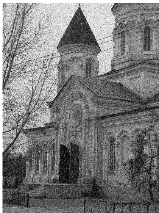
фрагмент юго-восточного фасада объекта культурного наследия;
