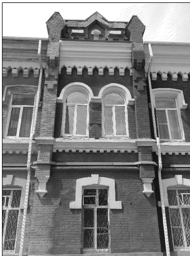
фрагмент главного восточного фасада (рядовая раскреповка);
