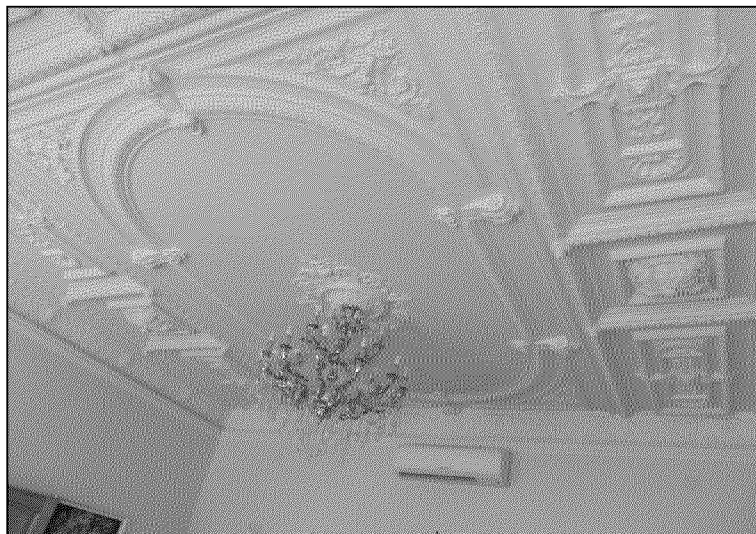
фрагмент помещения объекта культурного наследия № 9 (декор потолка)
