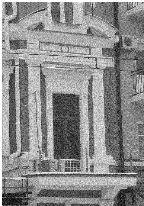
фрагмент восточной раскреповки главного южного фасада в уровне второго этажа (табличка с датой постройки «1894» над оконным проемом);
