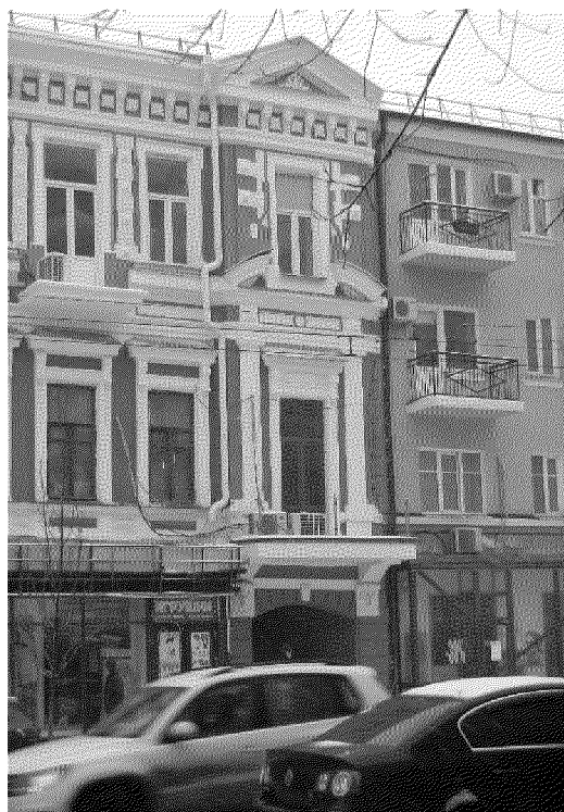
фрагмент главного южного фасада (крайняя восточная раскреповка);
