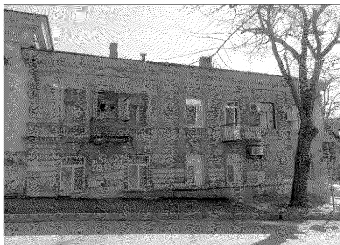
«Двухэтажное здание Ростовского отделения РОПиТ» (западный парадный фасад ;
