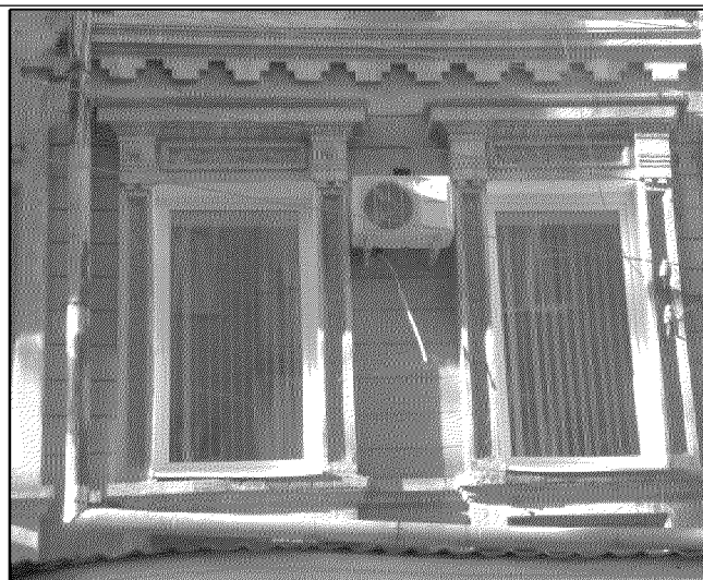
окна второго этажа главного восточного фасада;
