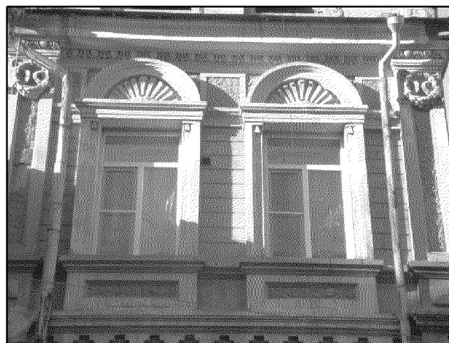
окна в уровне третьего этажа главного восточного фасада;
