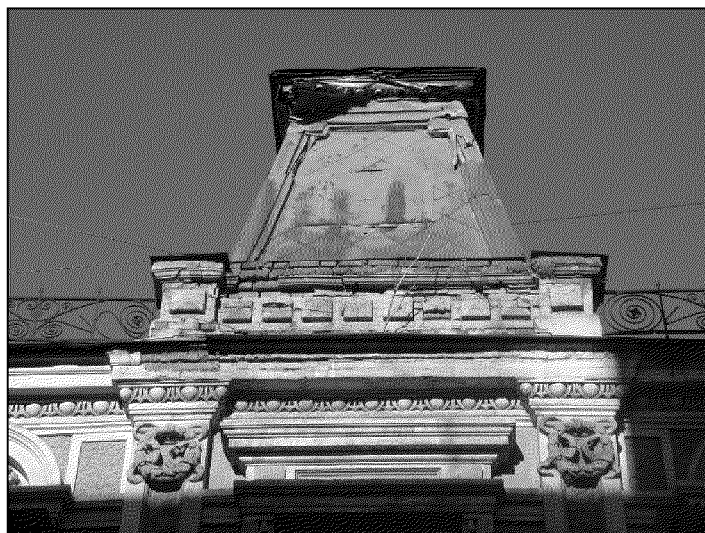
шатровая крыша центральной раскреповки;
