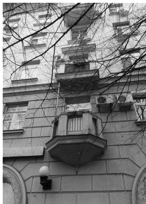
«Жилой дом с размещением на 1 этаже торговых помещений» (балконы южного фасада);
