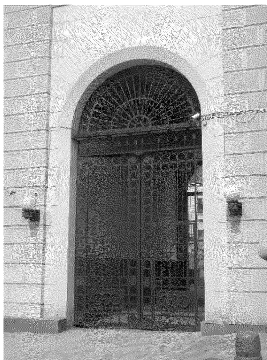
«Административное здание» (ворота западного внутридворового проезда южного фасада);
