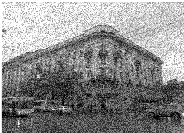
«Жилой дом с размещением на 1 этаже торговых помещений» (вид с юго-востока);
