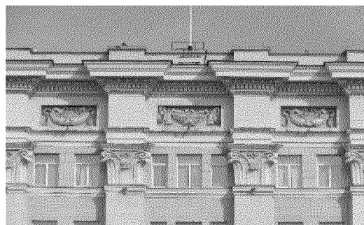
«Административное здание» (фрагмент главного южного фасада в уровне верхнего яруса);
