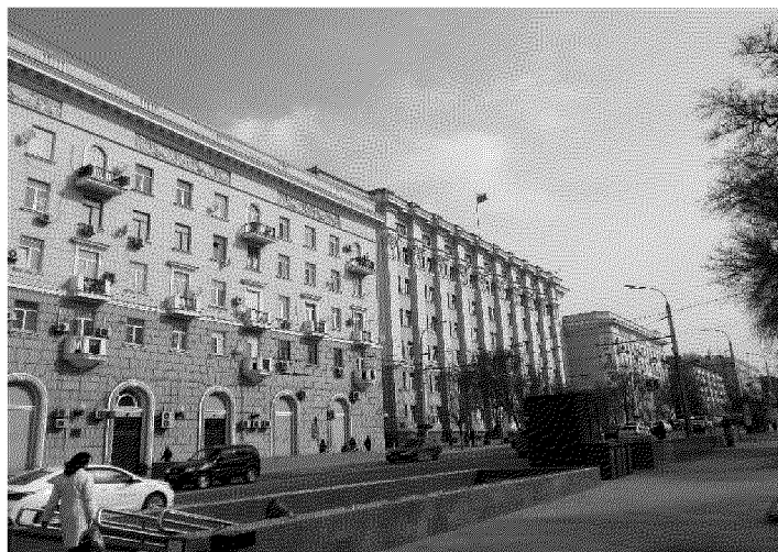
общий вид с юго-запада;
