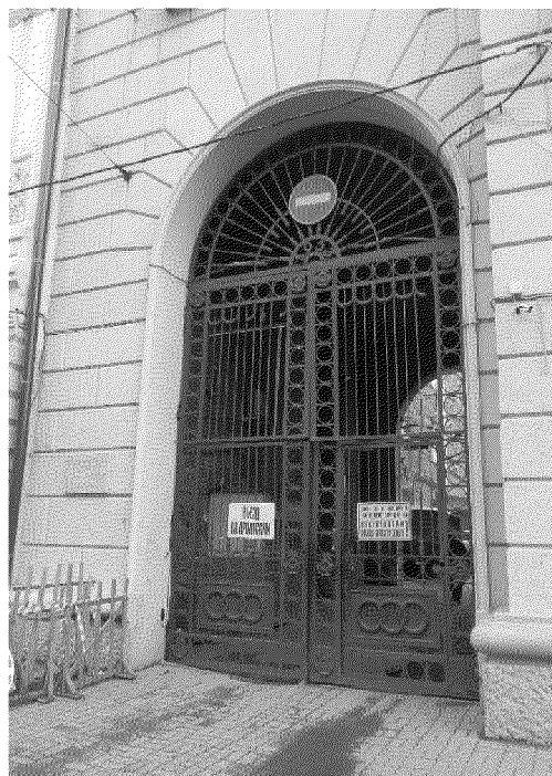
«Жилой дом с размещением кинотеатра на 1 этаже» (ворота внутридворового проезда в северной части западного парадного фасада);
