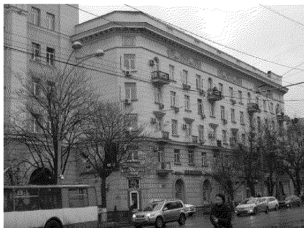
«Жилой дом с размещением на 1 этаже торговых помещений» (вид с юго-запада);
