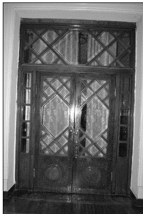
деревянная двупольная остекленная дверь в помещении № 4 второго этажа;
