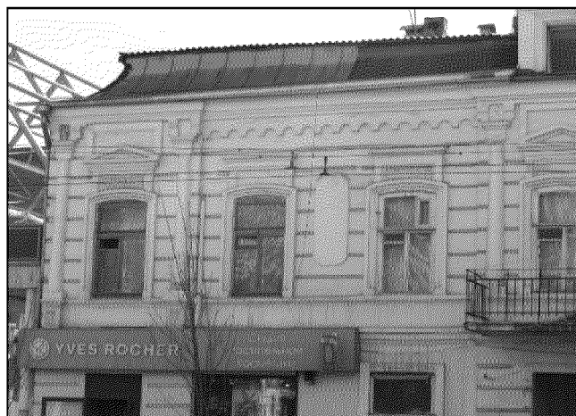
фрагмент восточной части главного северного фасада в уровне второго этажа;
