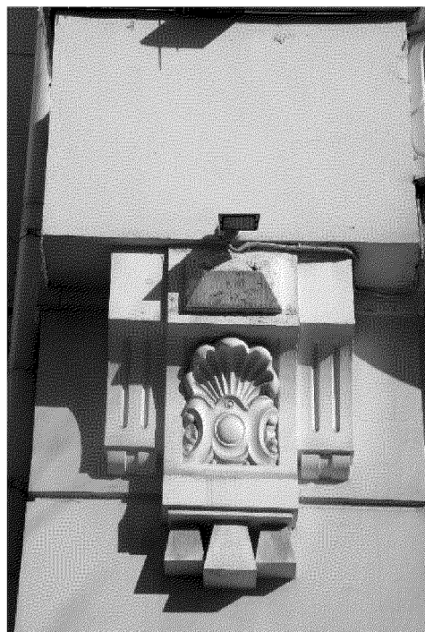
декоративный кронштейн в основании колонны парадного западного фасада;
