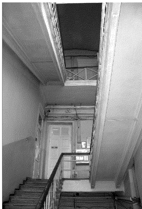
междуэтажная лестница, расположенная в западном крыле объекта культурного наследия;
