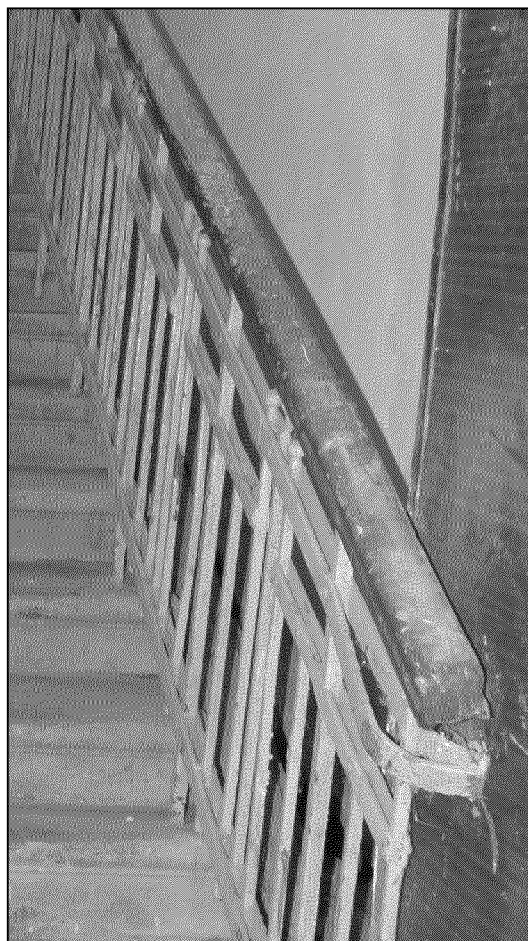
ограждение междуэтажной лестницы
