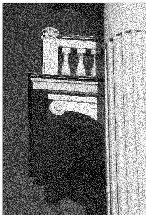
балкон 3-го этажа парадного западного фасада;
