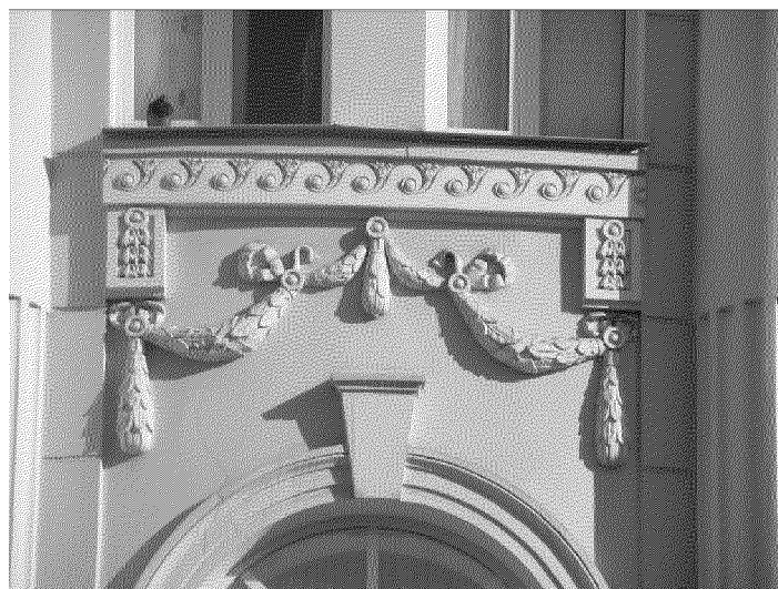
лепные гирлянды в подоконной части проема 3-го этажа парадного южного фасада;
