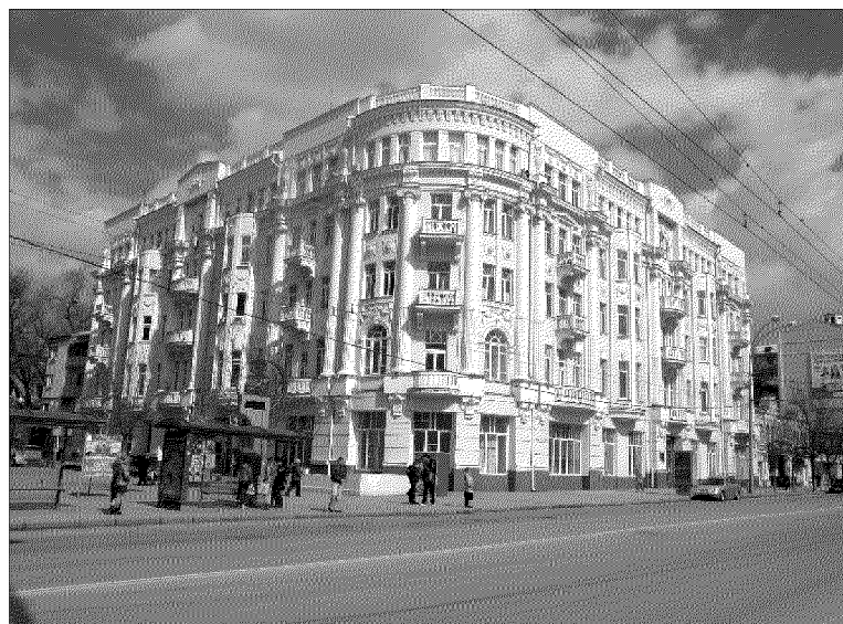
парадные западный и южный фасады;
