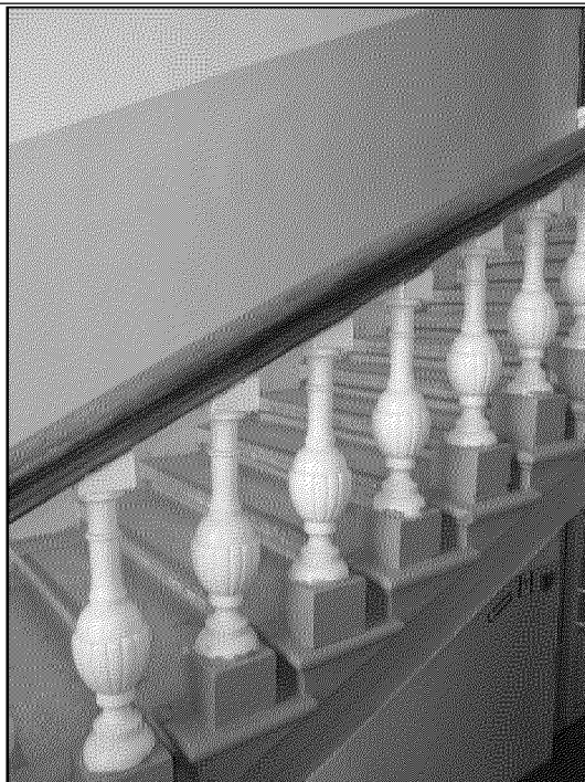
ограждение междуэтажной парадной лестницы
