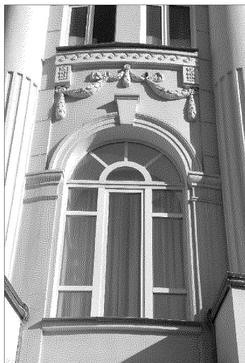
арочное окно 2-го этажа парадного южного фасада;
