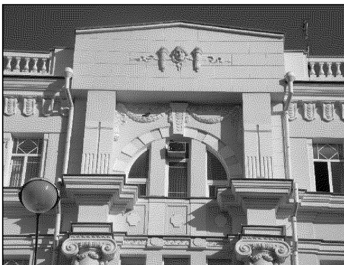
фрагмент раскреповки южного фасада;
