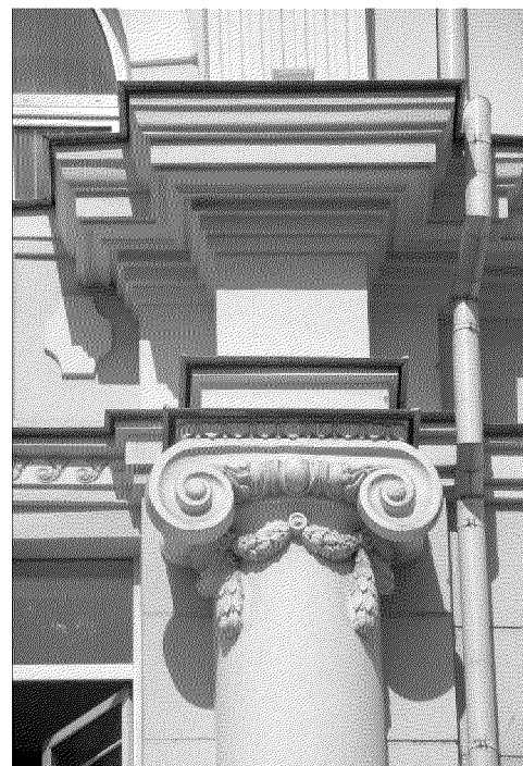
капитель простеночной колонны парадного южного фасада;
