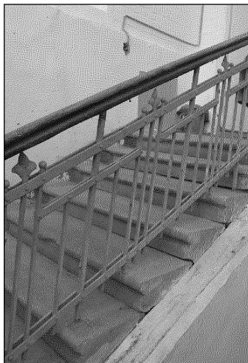
ограждение междуэтажной лестницы
