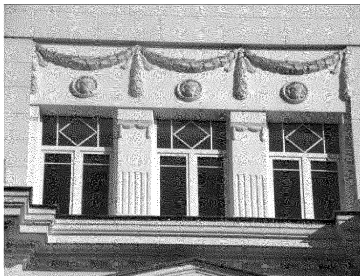
блок оконных проемов 5-го этажа парадного южного фасада;
