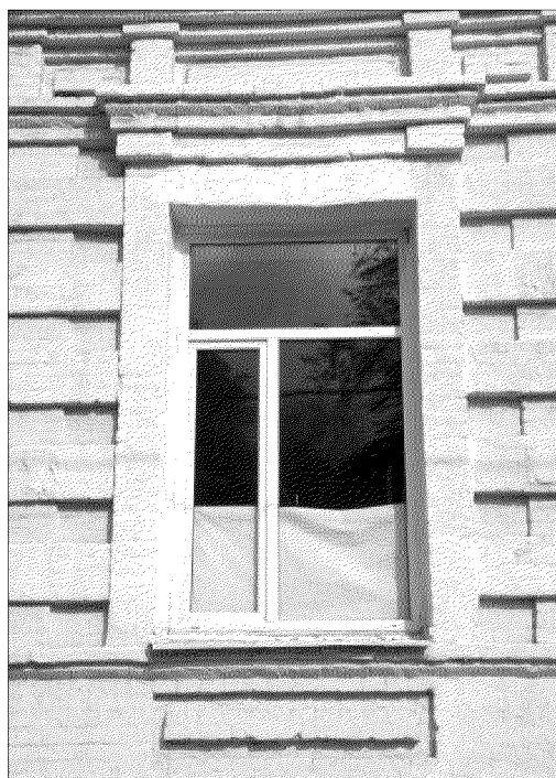
оформление оконного проема
