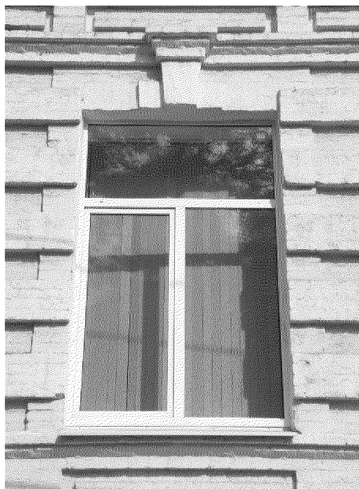
оформление оконного проема;
