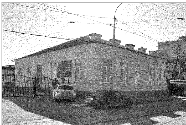
общий вид объекта культурного наследия с северо-запада;
