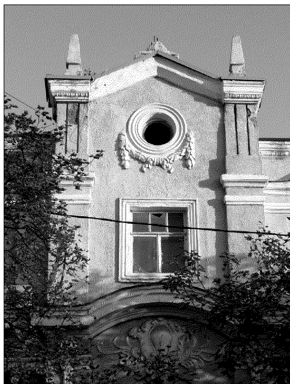
фрагмент центральной раскреповки парадного северного фасада;
