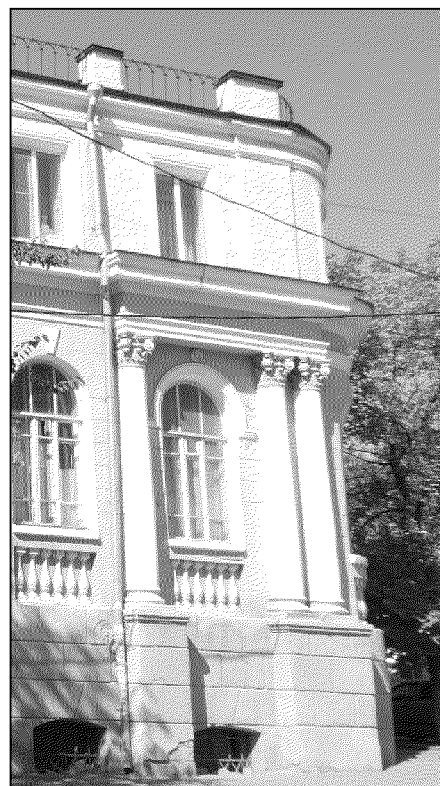
северная раскреповка парадного восточного фасада;
