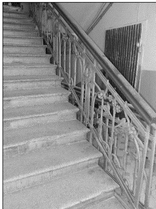
внутренняя междуэтажная парадная лестница в уровне первого этажа, расположенная в центральной части объекта культурного наследия;
