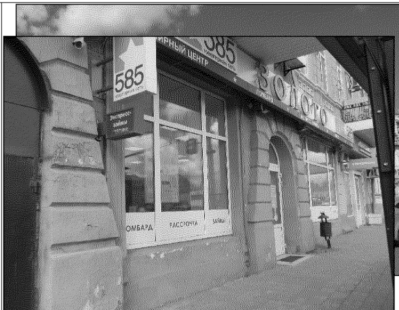
южная часть главного восточного фасада; фрагмент главного восточного фасада в уровне первого этажа;
