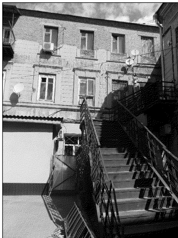
южный дворовый фасад объекта культурного наследия
