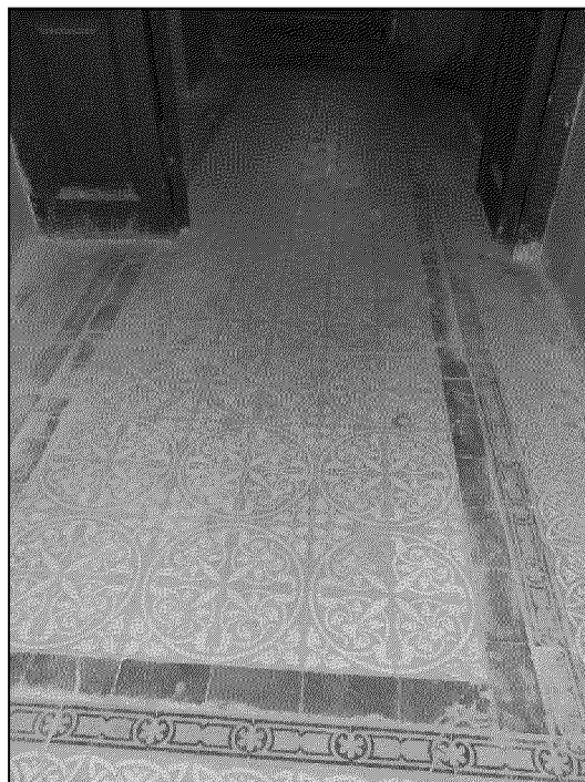
первоначальная керамическая плитка покрытия пола вестибюля парадного входа;
