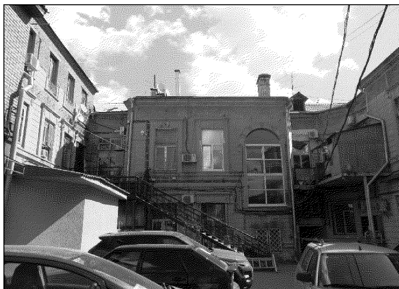
западный дворовый фасад объекта культурного наследия;
