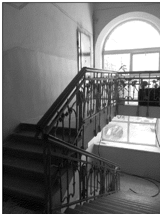
внутренняя междуэтажная парадная лестница в уровне второго этажа, расположенная в центральной части объекта культурного наследия;
