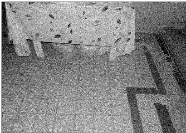
первоначальная керамическая плитка покрытия пола лестничной площадки в уровне второго этажа
