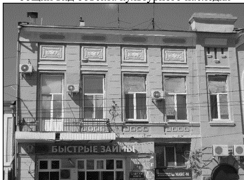
главный восточный фасад;
