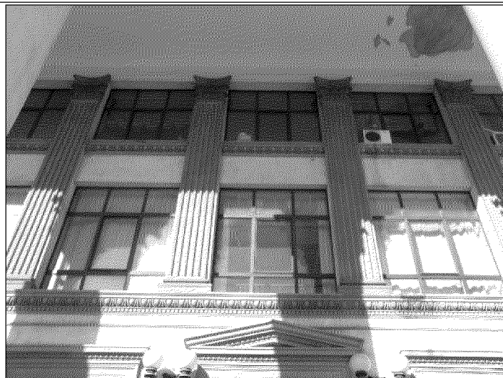
пилястры, расположенные в простенках оконных проемов 2-го и 3-го этажей;
