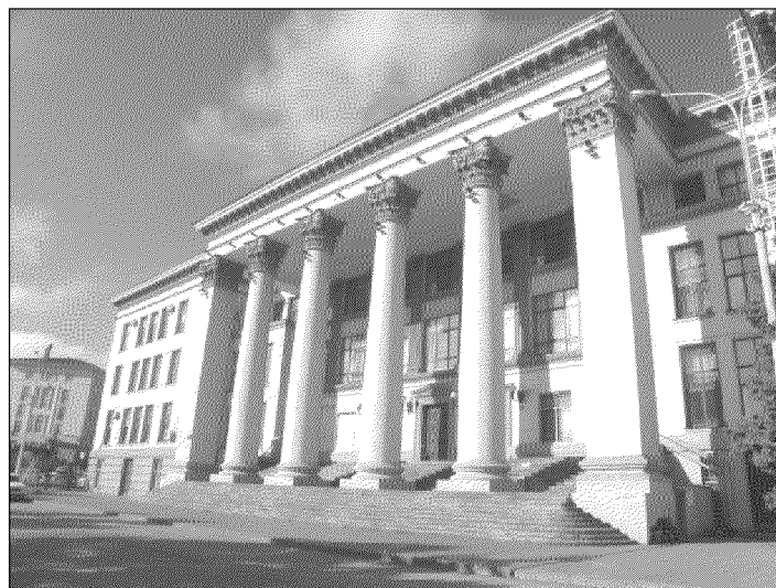
колоннада портика главного фасада;
