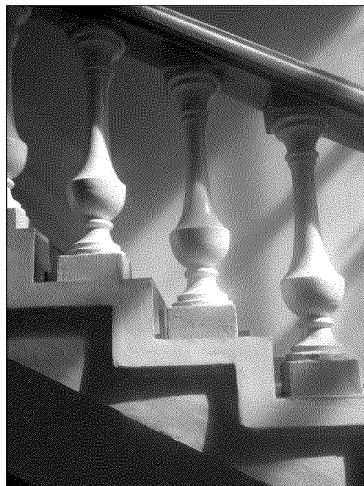
ограждение междуэтажной лестницы
