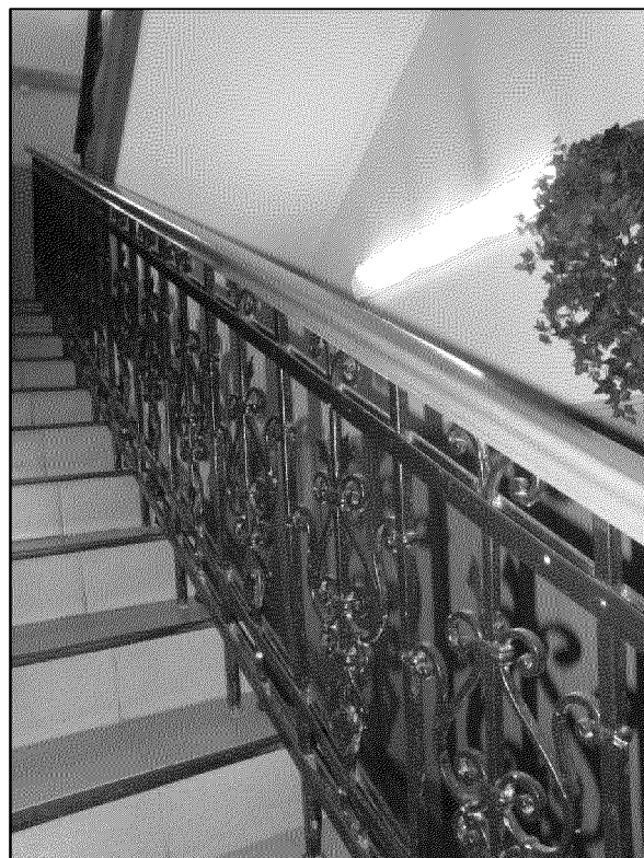
ограждение междуэтажной парадной лестницы;
