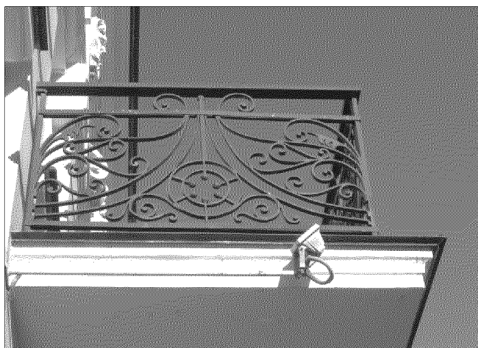
ограждение балкона второго этажа на парадном восточном фасаде;
