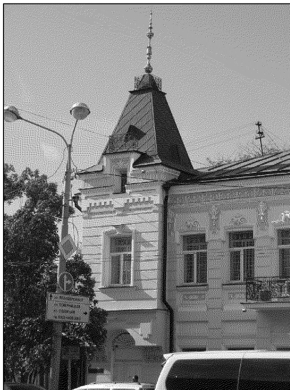
боковая раскреповка парадного восточного фасада;
