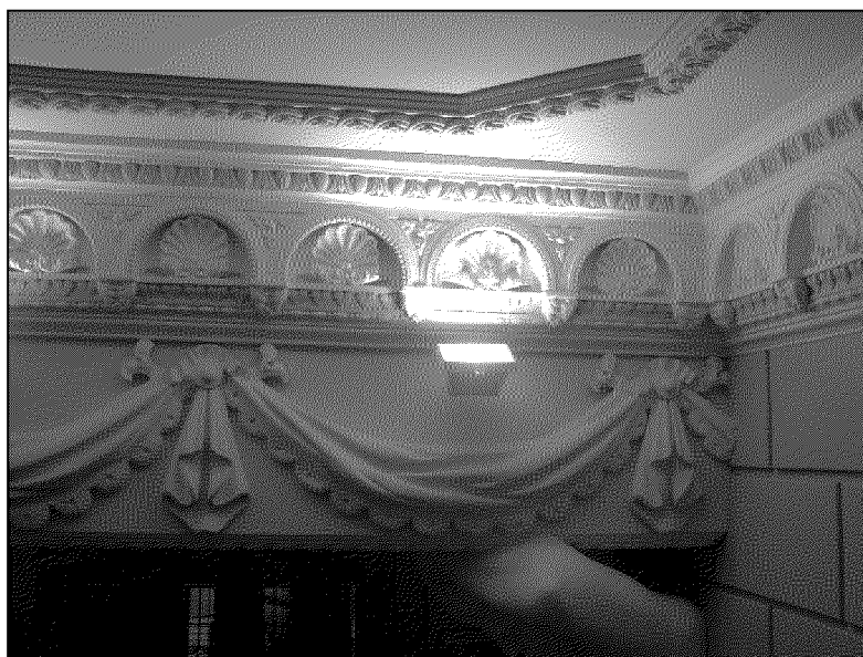
оформление стен в интерьере лестничной клетки
