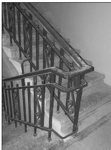
междуэтажная лестница в центральной части объекта культурного наследия;
