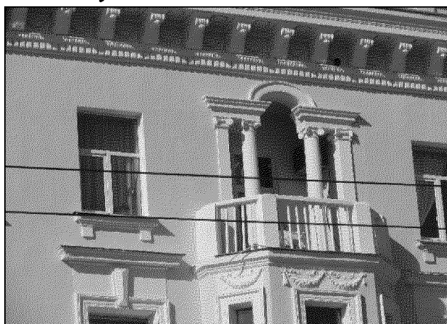
фрагмент восточного фасада;
