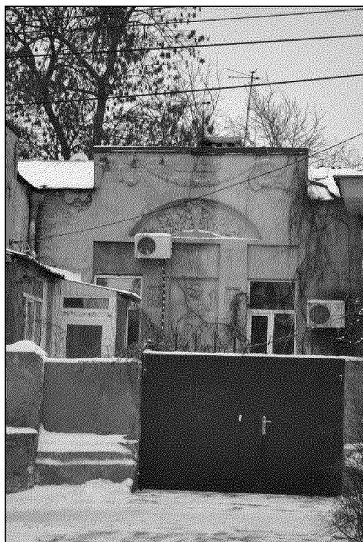
центральная часть южного фасада;
