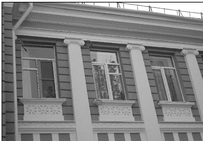
фрагмент главного северного фасада в уровне второго этажа;
