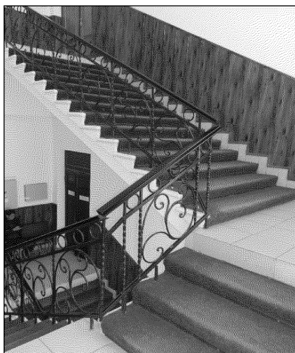
внутренняя междуэтажная лестница в юго-восточной части объекта культурного наследия
