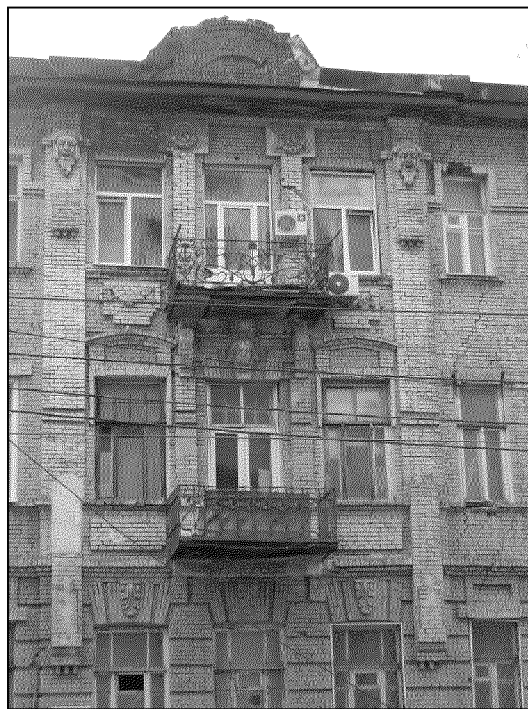
фрагмент главного южного фасада в уровне второго, третьего этажей;
