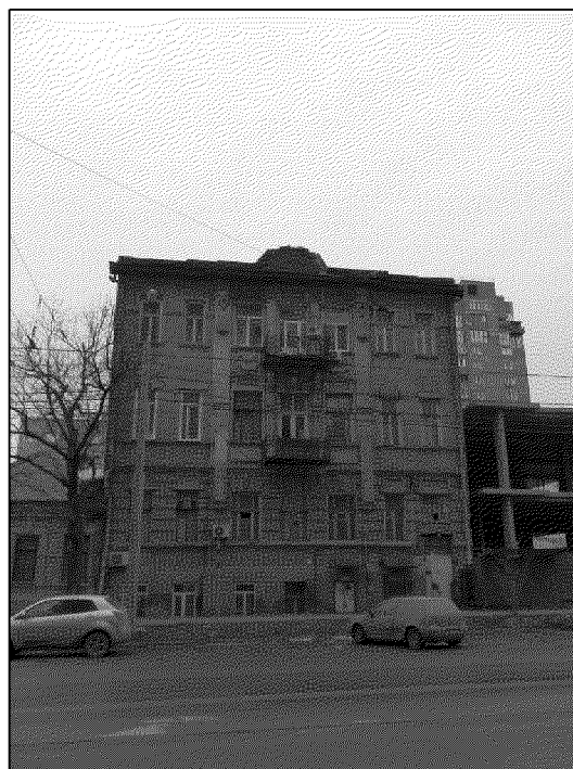
главный южный фасад;
