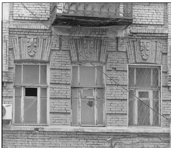
фрагмент главного южного фасада в уровне первого этажа;
