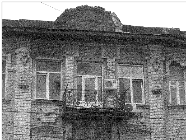
фрагмент главного южного фасада в уровне третьего этажа;
