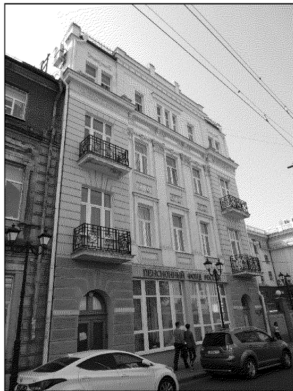
главный северный фасад;
