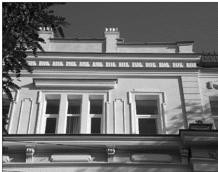
фрагмент главного северного фасада в уровне второго, третьего этажей;
