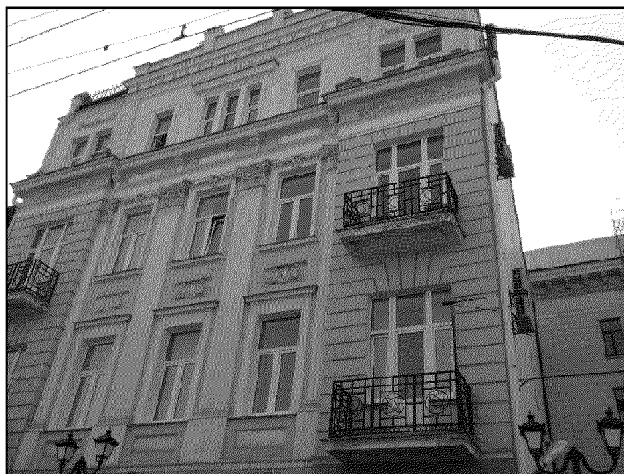
фрагмент главного северного фасада в уровне четвертого этажа;
