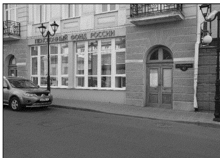
фрагмент главного северного фасада в уровне первого этажа;
