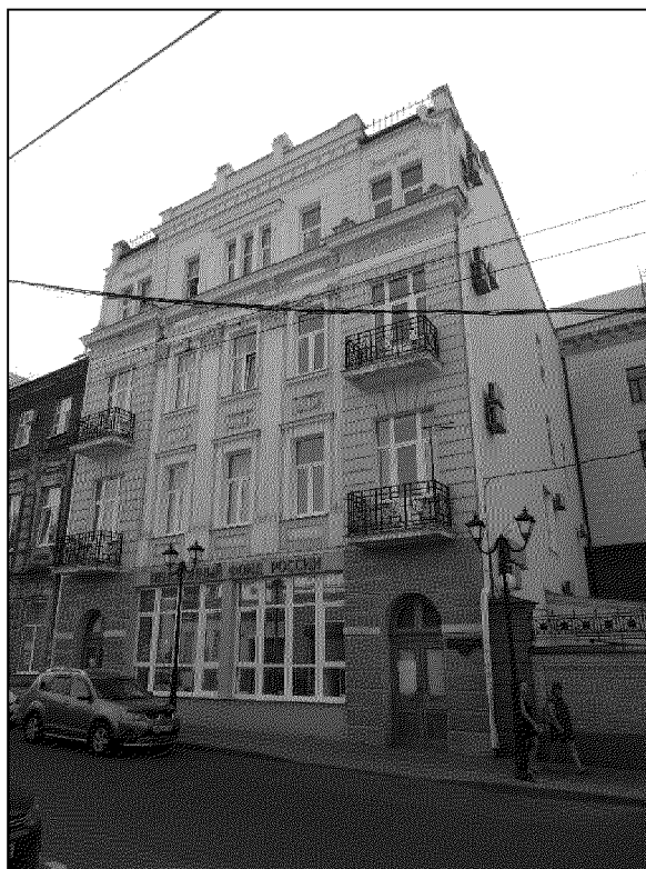
вид с северо-запада
