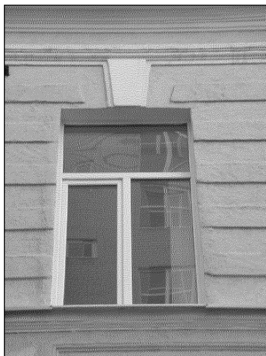
окно второго этажа главного южного фасада;
