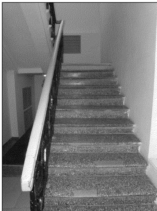
междуэтажная лестница, расположенная в западной части объекта культурного наследия;
