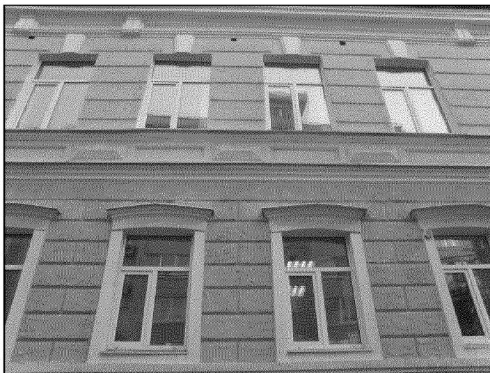
оконные оформления первого и второго этажей главного южного фасада;
