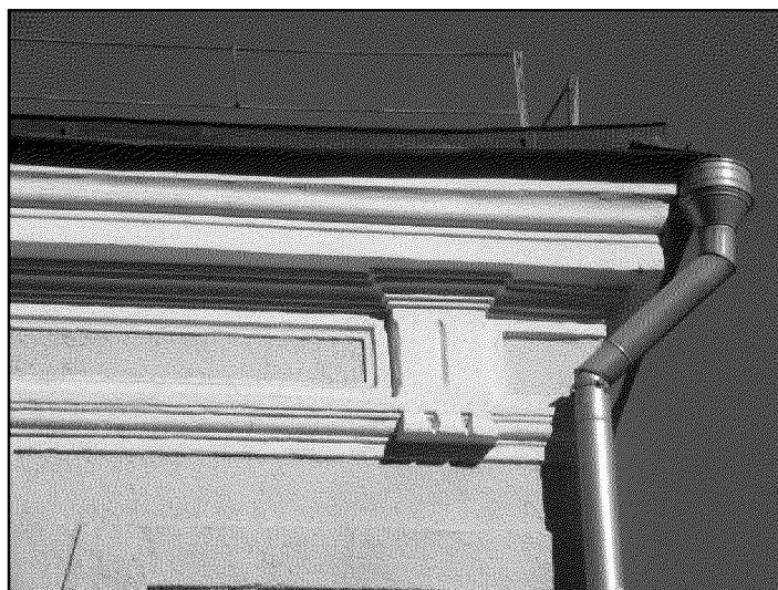
венчающий карниз главного южного фасада
