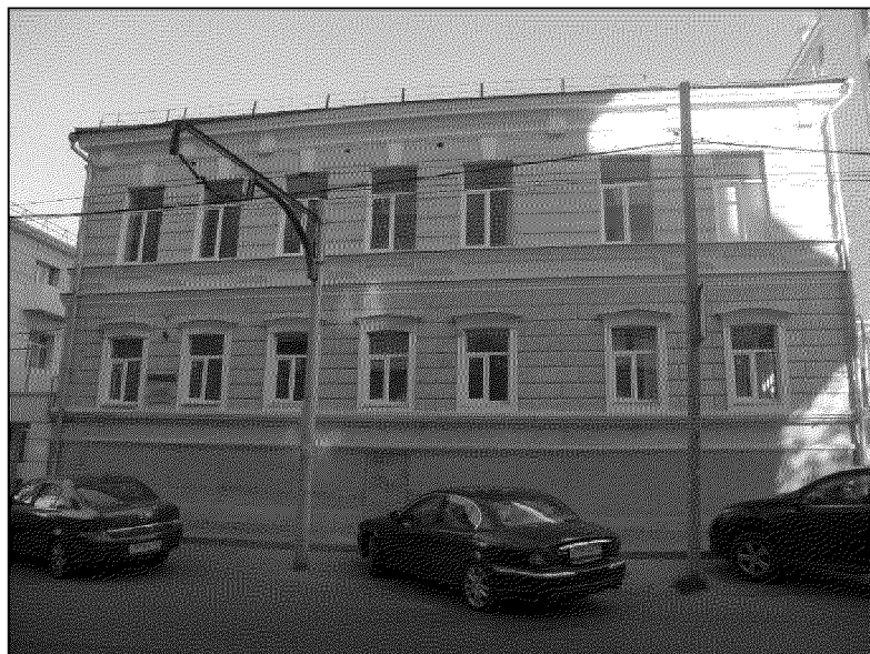
главный южный фасад;
