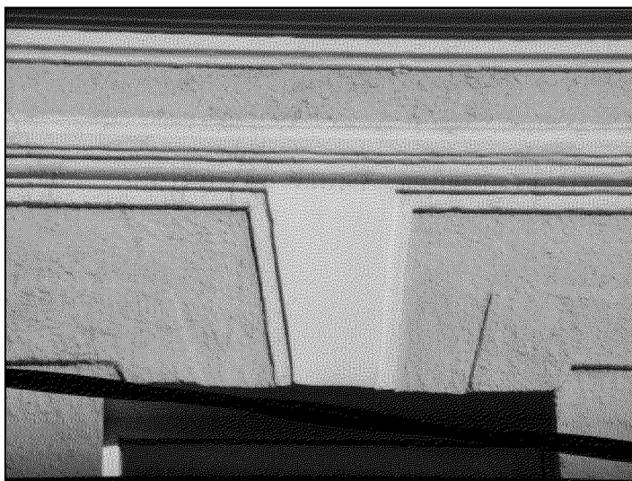
трапециевидный замок перемычки оконного проема 2-го этажа главного южного фасада;
