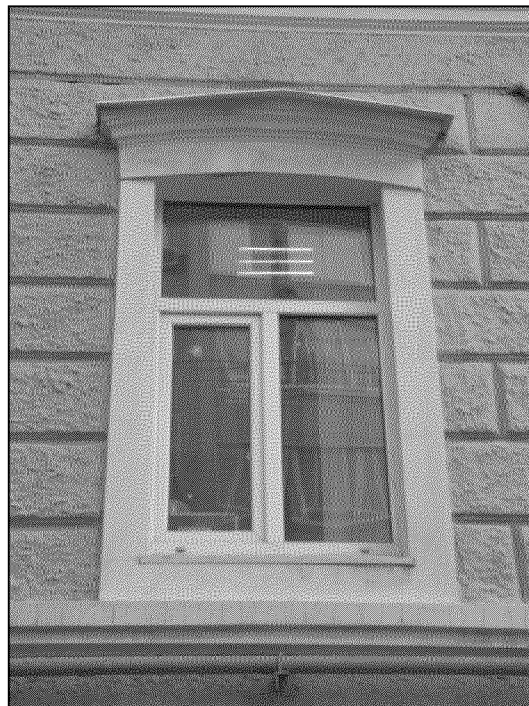
окно первого этажа главного южного фасада;
