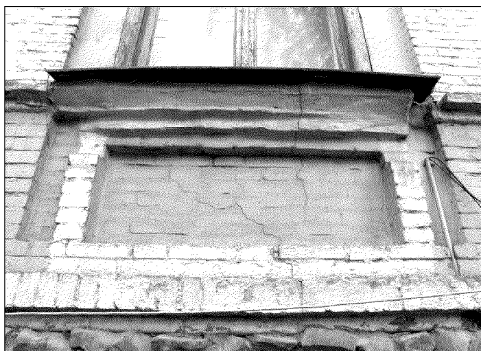
подоконная ниша оконного проема первого этажа
