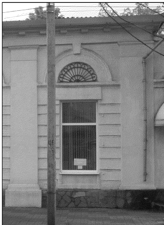
руст простенков оконных проемов
