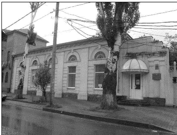
главный южный фасад;
