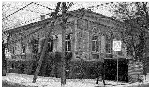
парадные южный и восточный фасады;
