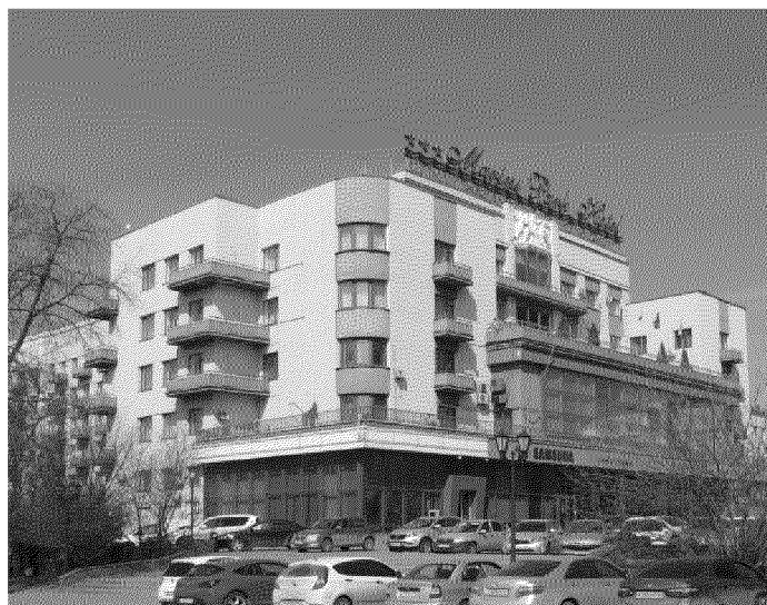
вид объекта с юго-востока
