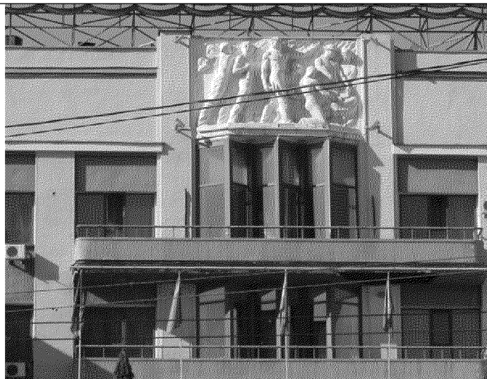
фрагмент верхней центральной части восточного парадного фасада объекта
