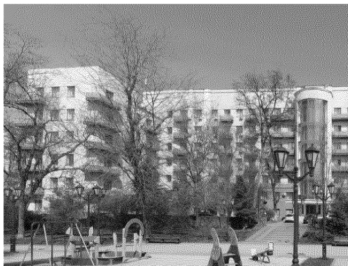
фрагмент южного парадного фасада объекта
