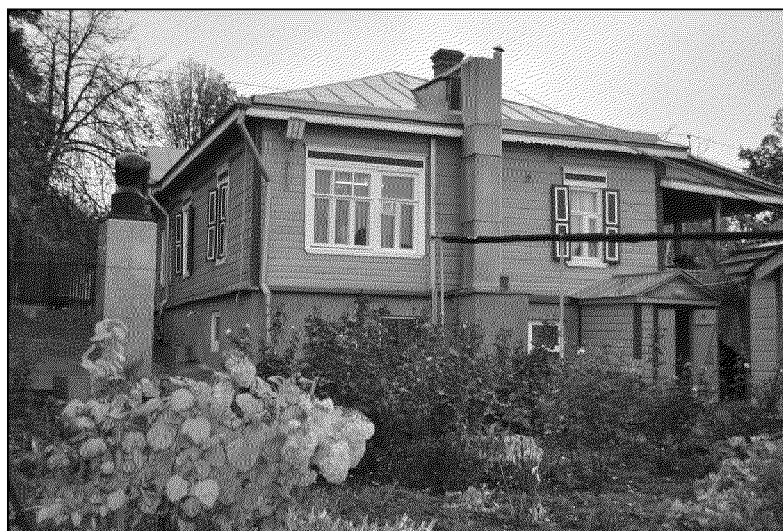
дворовый северо-восточный фасад;
