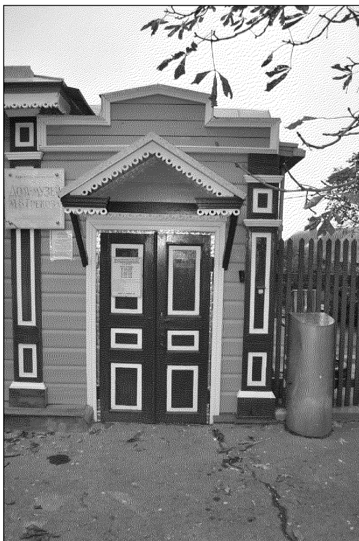
козырек главного входа;
