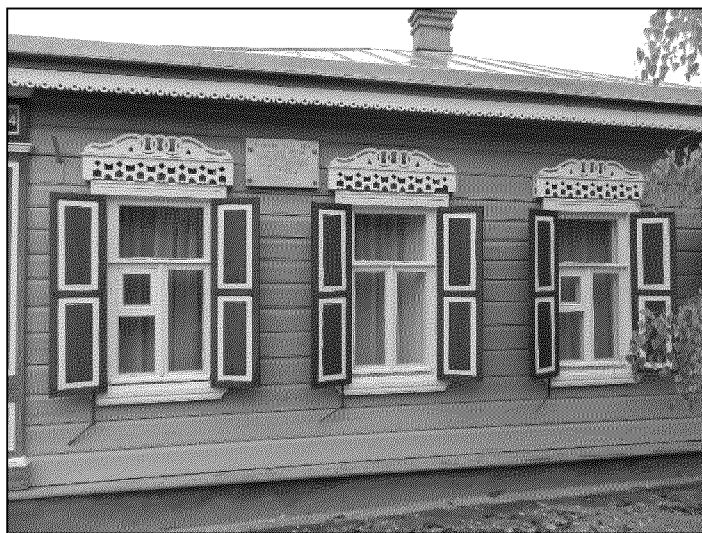
окна главного юго-западного фасада;
