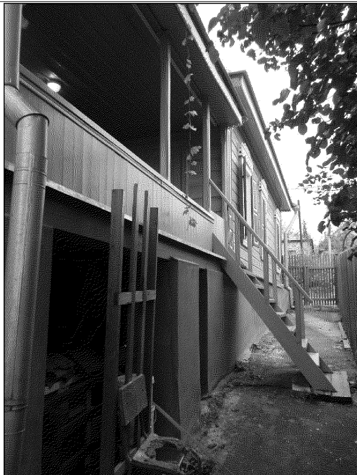
дворовый северо-западный фасад
