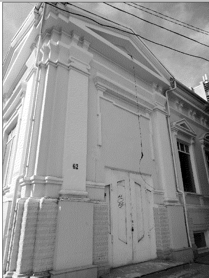
фрагмент северного фасада (портал восточного входа);
