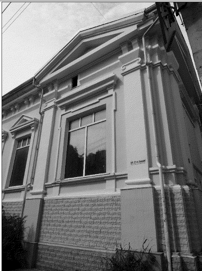
фрагмент восточного фасада;
