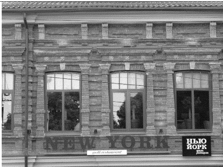
фрагмент южного фасада;
