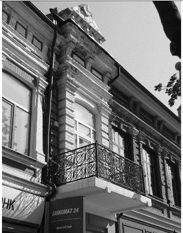
фрагмент южного фасада
