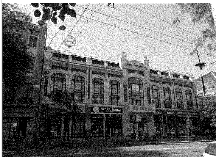
главный северный фасад объекта культурного наследия
