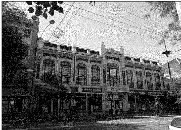
главный северный фасад объекта культурного наследия
