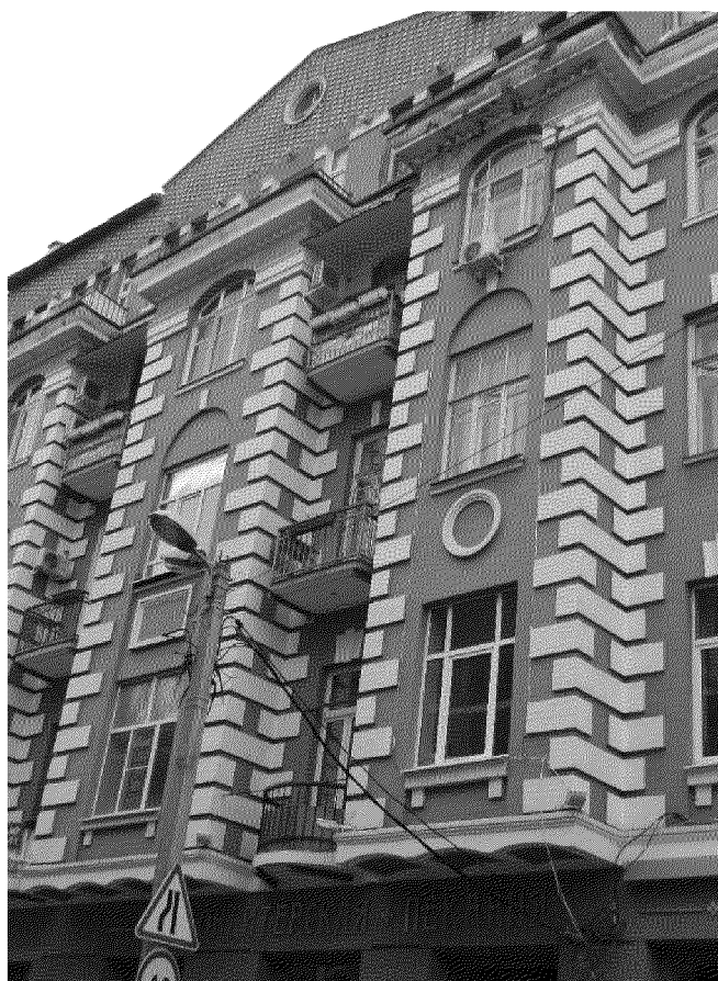
фрагмент восточного парадного фасада (центральная часть);
