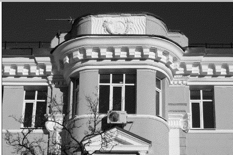
эркер и аттик центральной раскреповки южного фасада;
