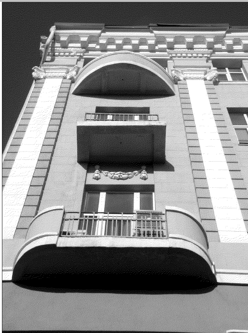
балконы западной боковой раскреповки южного фасада;
