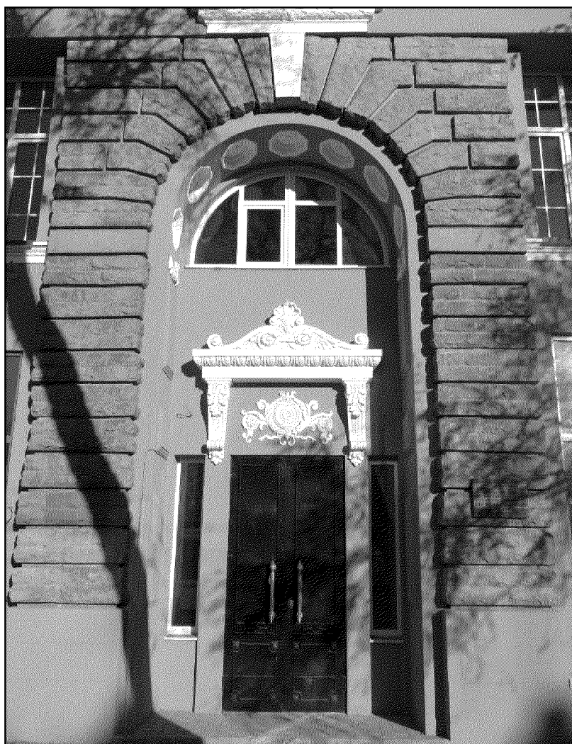
портал парадного входа, расположенный в полуциркульной арочной нише южного фасада;
